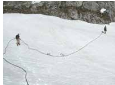
Verlegen der Wasserleitung Mitte Juni
